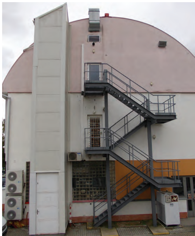
Obr. 7: Pohled na dvanáctimetrovou věž zařízení pro kalibraci hladinoměrů
